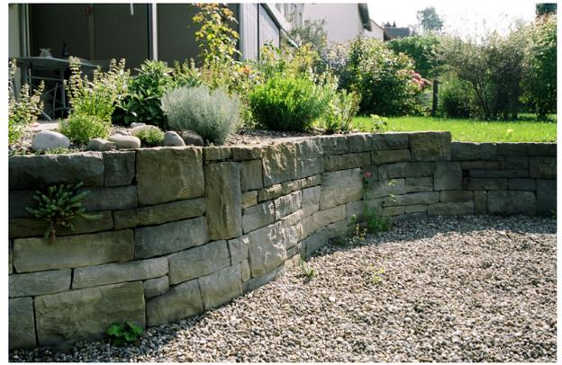
Abbildung 26: Eine neue professionell gebaute Trockenmauer kann auch bei sehr geringem Unterhalt Jahrhunderte überdauern. <sup>25</sup>
